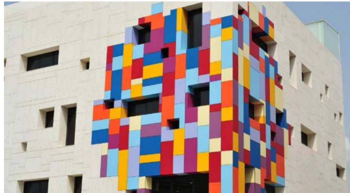
Il **fibrocemento** è una miscela di cemento e fibre di cellulosa il quale permette di ottenere un prodotto con ottime caratteristiche di durabilità, tenacia, resistenza meccanica e termica. Disponibile in moltissime colorazioni in massa. Materiale perfettamente riciclabile quindi con valenza in ambito ecologico.
