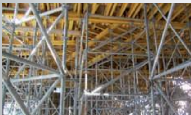
Albero di testa con fssaggio per correnti PI e trave in legno TI
