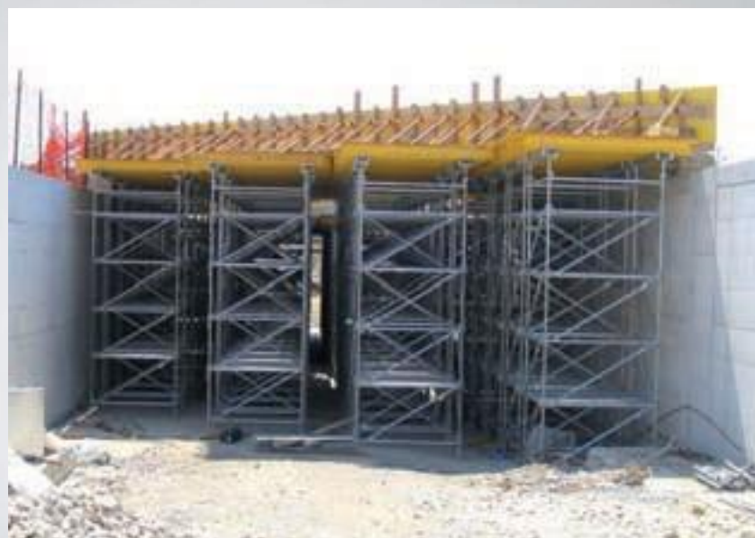
Schema tipo per torre con carico ammissibile di 30 kN per stelo
