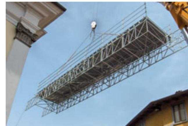
Les différentes parties peuvent être assemblées au sol en toute sécurité. Seulement quand la structure est achevée on procède à la positionner avec des moyens de soulèvement (voir la photo ci-dessus).
