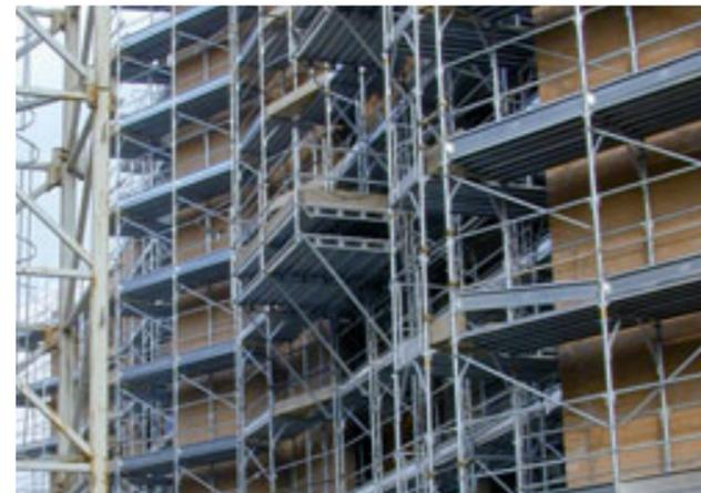
Les plates-formes de chargement en saillie, utilisés aussi en combinaison avec les cadres préfabriqués, arrivent à des portées de 450 kg/m<sup>2</sup>. Elles peuvent être simples (180 cm x 180/250 cm) ou composées (180 cm x 360/500 cm), pour faciliter l'opération d'enlèvement de la fourche des palettes portées en hauteur.
