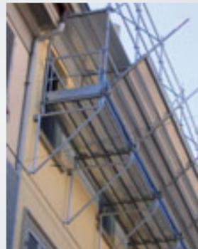
Le plancher de protection est créé sur la traverse de la console elle-même.
