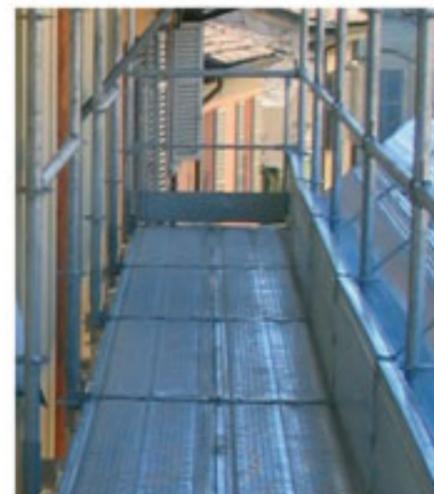
On peut appliquer la console sur une plaque que l'on cheville au mur, ou bien en utilisant une barre passante (les actions horizontales à tirer et à pousser qui agissent sur la console partent de 1000 daN).
