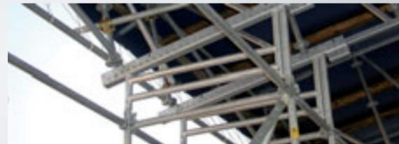
Pour les positionner on utilise des éléments d'appui plats ou inclinés à 12,5° pour les couvertures.
