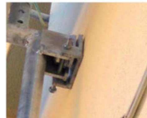
Pour éviter que la console ne se soulève en cas de fortes rafales de vent, on a prévu un boulon dans la partie inférieure de l'accrochage.
