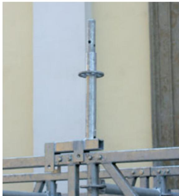
On peut installer l'échafaudage au-dessus des poutres grâce aux éléments de redépart qui sont fixés avec de simples goujons. Le disque perforé de l'élément de redépart est placé à une distance telle qu'il y ait toujours 50 cm entre lui et la poutre inférieure. (voir la photo).
