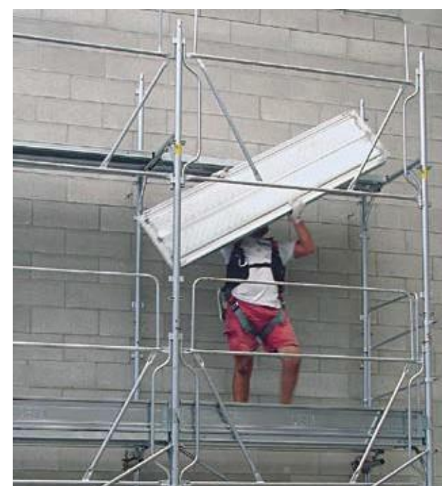
Completamento del piano di calpestio
