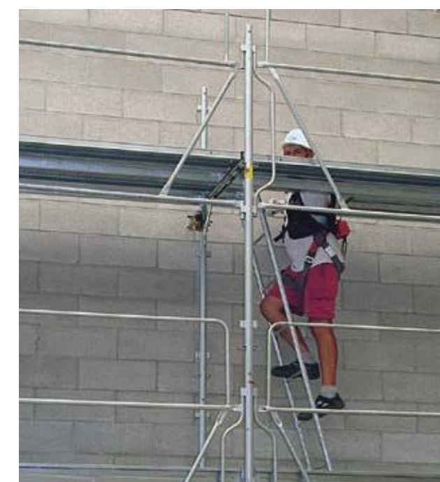
Accesso al piano superiore già in sicurezza
