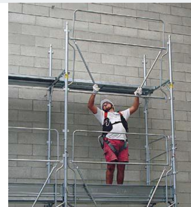
Montaggio del telaietto di parapetto
